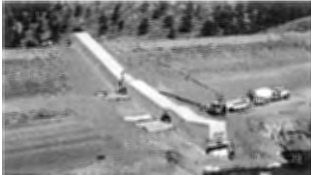
Final concrete pour at Nichols Dam (WCM photo)
