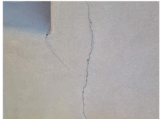
Stucco damage | A29
